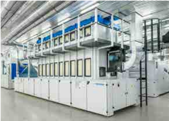
Doğrudan temizleyici CLEANOMAT CL-C3 ile birleştirilmiş entegre mikser MX-I 10
